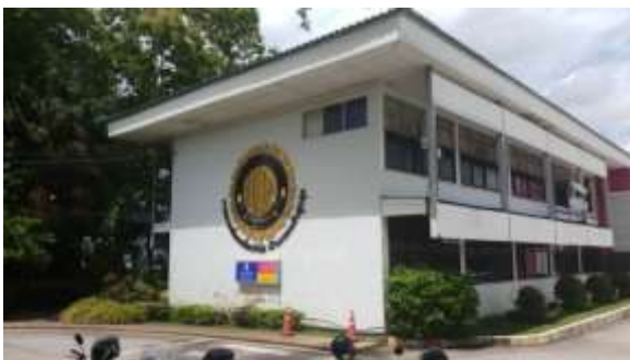
อาคารมีการออกแบบออกแบบใช้สีที่เอื้อต่อการเพิ่มแสงสว่างและลดการดูดความร้อนภายนอก
