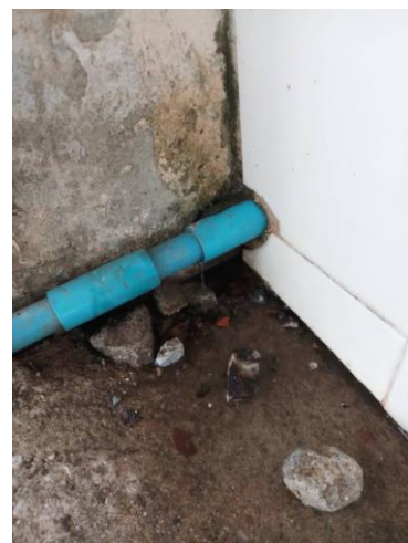
ภาพ : แสดงการตรวจสอบและซ่อมท่อน้ำประปาที่รั่วไหล
