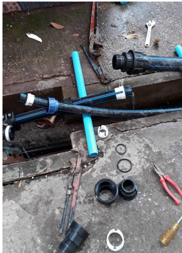
ภาพ : แสดงตรวจสอบและซ่อมท่อน้ำประปาที่รั่วไหล (ต่อ)
