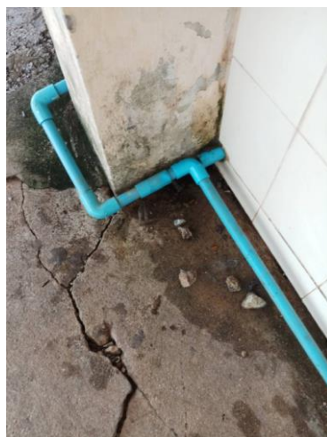
ภาพ : แสดงการตรวจสอบและซ่อมท่อน้ำประปาที่รั่วไหล
