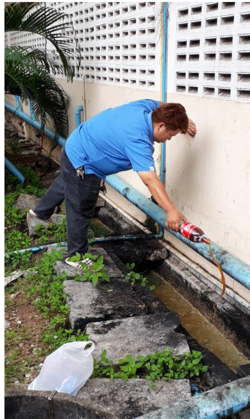
ภาพ : แสดงการเติม EM ลงในระบบบำบัดน้ำเสียโรงเรียนพะเยาพิทยาคม
