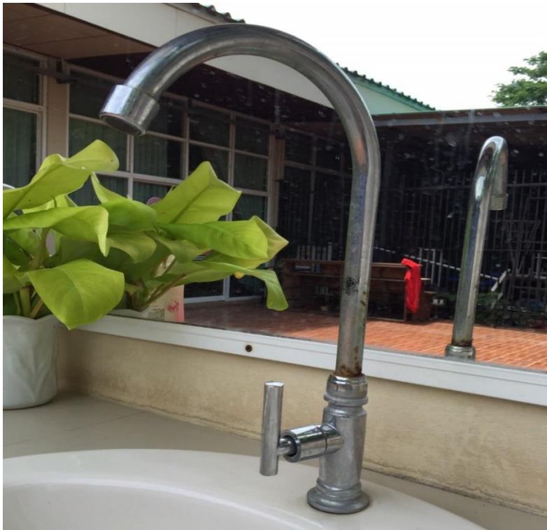
ภาพ : แสดงก๊อกน้ำรุ่นประหยัดน้ำจากห้องน้ำหอประชุม
