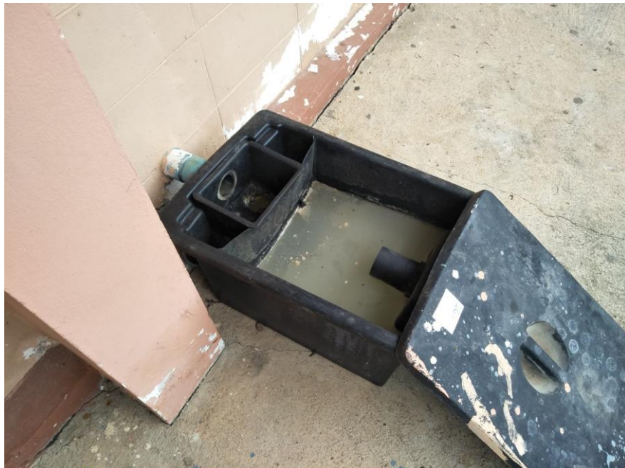
ภาพ : แสดงการนำไขมันออกจากถังดักไขมัน
