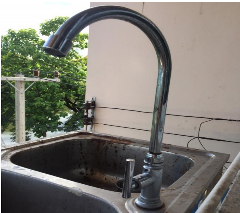
ภาพ : แสดงก๊อกน้ำรุ่นประหยัดน้ำจากห้องพักรูอาคาร 3
